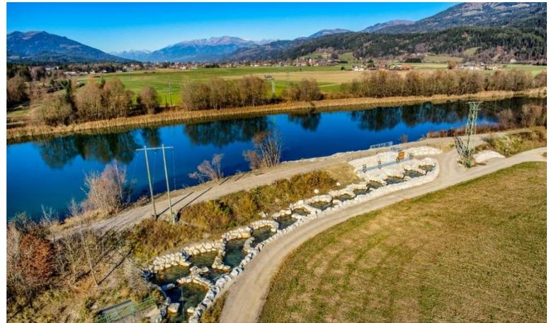
Unterwasserseitige Anbindung des Umgehungsgerinnes an die Drau, Naturnaher Beckenpass, strukturiertes Umgehungsgerinne unterhalb der Kellerberger Brücke und im Bereich der Fischzucht bzw. Beckenpass zur Anbindung des Umgehungsgerinnes an die Drau im Oberwasser
